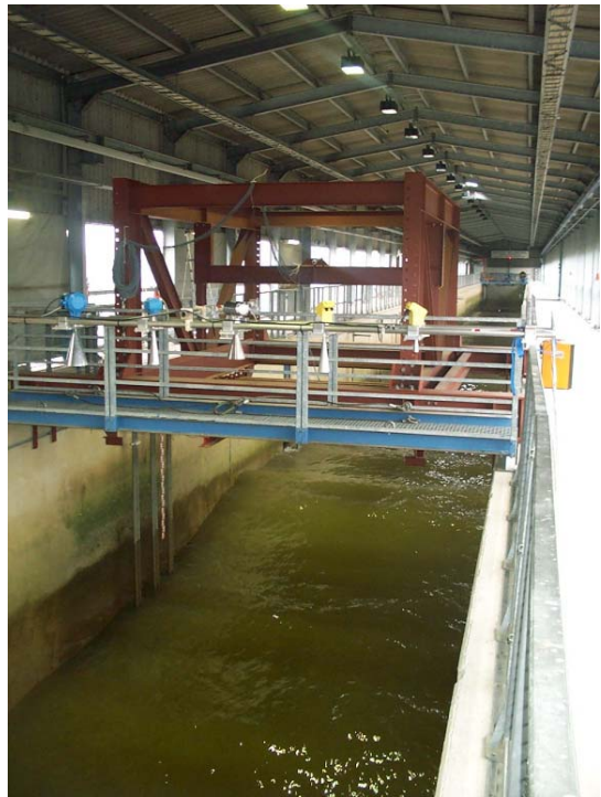
Bild 10: Messaufbau für Radarsensoren im "Großen Wellenkanal" in Hannover
