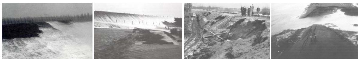
Abb. 1: Stufen des Versagensmechanismus „Erosion der Binnenböschung nach Wellenüberlauf“
